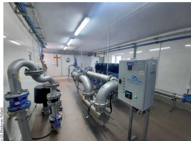
Przebudowano m.in. stację uzdatniania wody w Rogoźnicy
