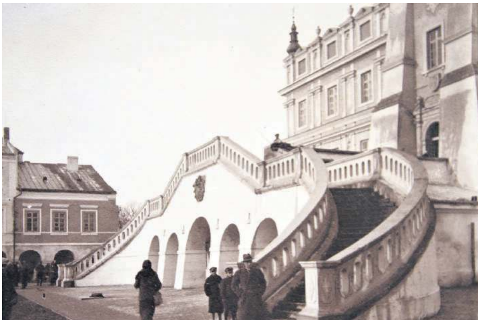
Przy schodach zamojskiego Ratusza.
