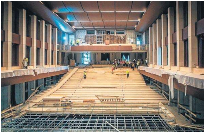
Trwają prace związane z zagospodarowaniem i wykończeniem wnętrza
