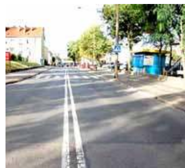
Powiat nadal czeka na oficjalną decyzję o dofinansowaniu przebudowy ul. Pierwszej Brygady
