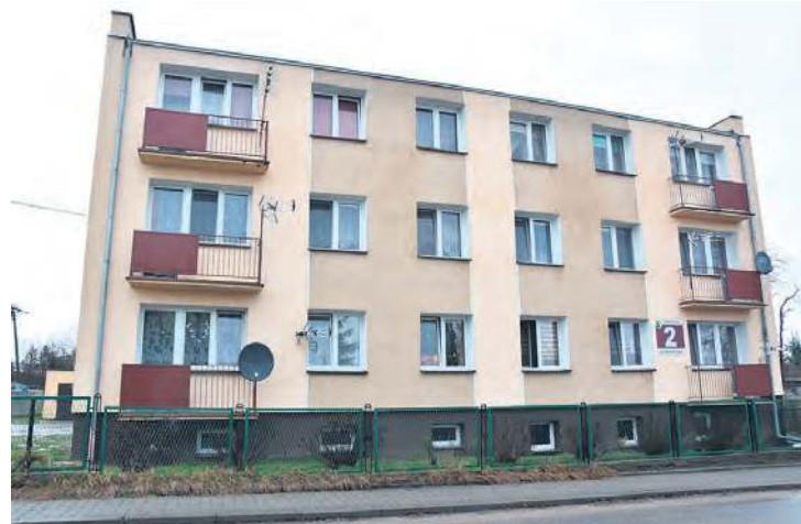
65.000 zł ma wynieść modernizacja ciepłociągu między budynkami położonymi przy ul. Słonecznej 2 i 4 w Gostycynie.
