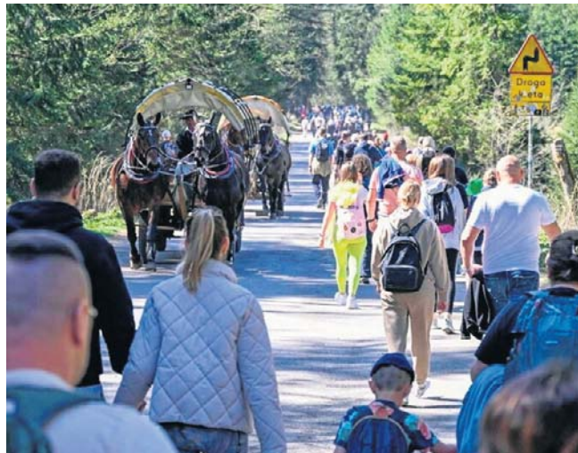
Zatłoczona zwykle droga do Morskiego Oka jest zamknięta. 25 maja zaczęto się układanie nowej warstwy asfaltu
