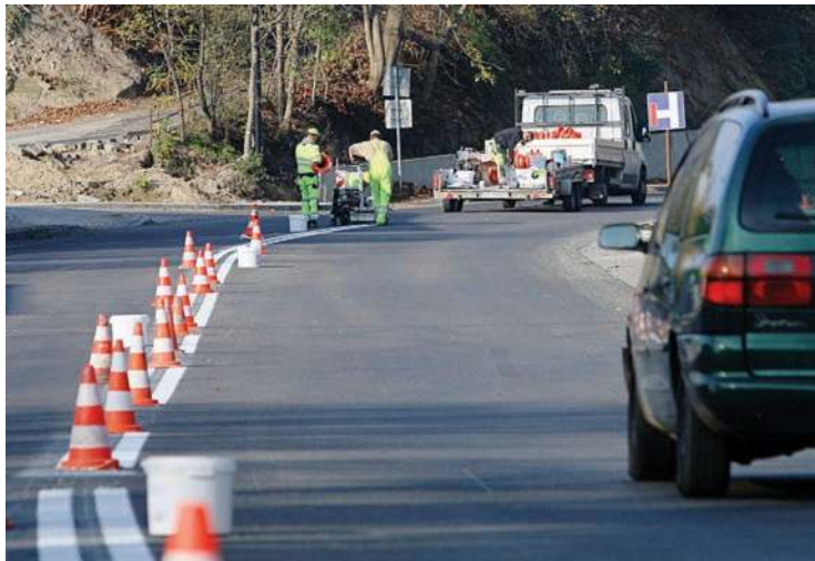
Przebudowa ulicy Kalinowszczyzna, a tym samym utrudnienia w ruchu, powinna się zakończyć przed zaplanowanym terminem
