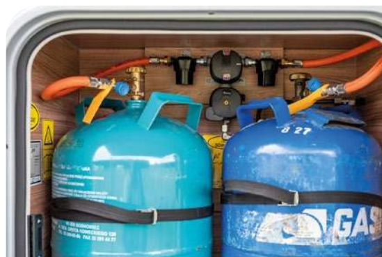
Reduktor gazowy z automatycznym przełączaniem butli to wygodne rozwiązanie, dzięki któremu nie trzeba wstawać w nocy, aby przepiąć pustą butlę na pełną
