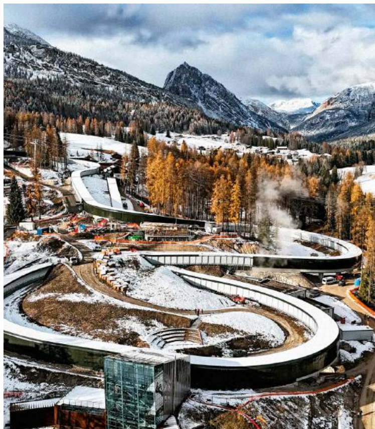
Cortina d'Ampezzo, budowa toru bobslejowego. Obiekty mają być oddane na ostatnią chwilę.
