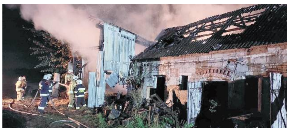
Strażacy gasili pożar przez ponad 3 godziny (fot. OSP Stoczek Łukowski)
