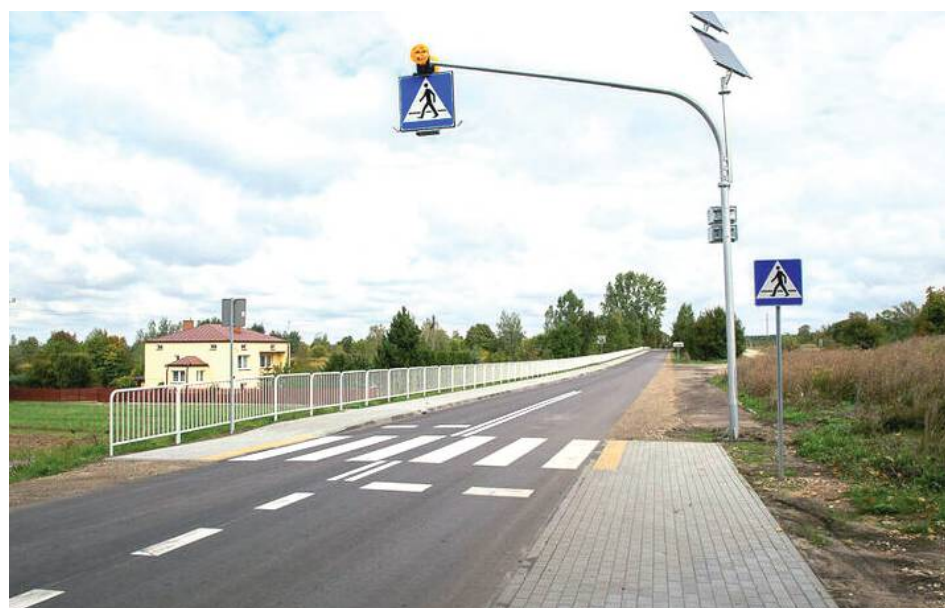
Nowa nawierzchnia, przejścia dla pieszych, chodnik i barierki przy ul. Kolejowej w Niemcach
