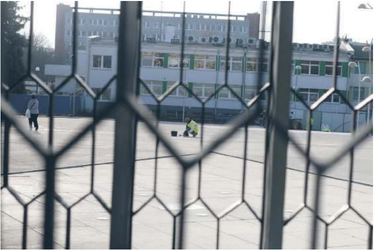
Na placu trwają jeszcze prace wykończeniowe
