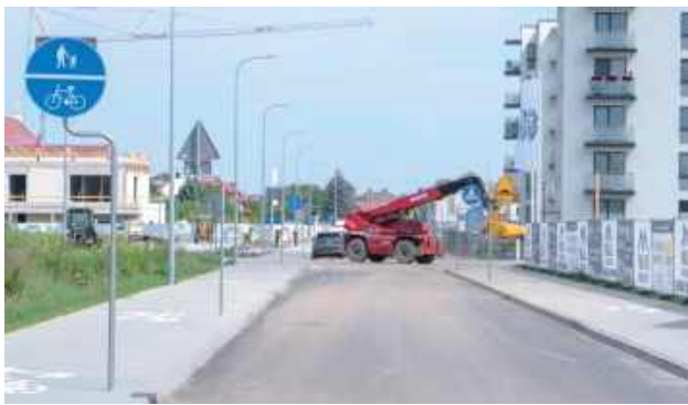
Budowa została wsparta pieniędzmi z Rządowego Funduszu Rozwoju Dróg
