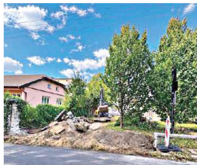
Prace przy budowie nowego objazdu
