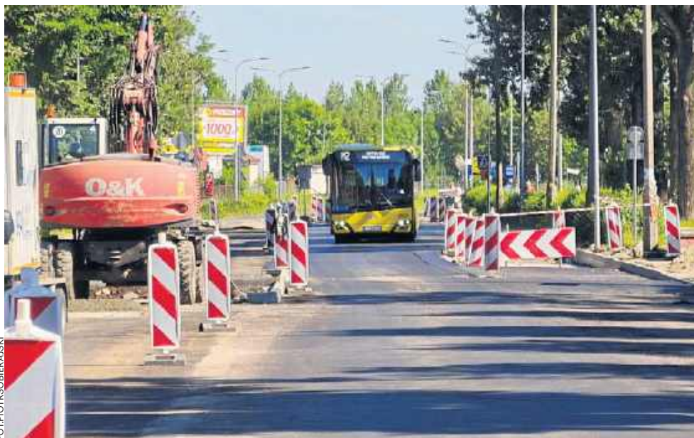
W Dąbrowie Górniczej Gołonogu trwa jedna z największych drogowych inwestycji w mieście. Remontowane są ul. Wybickiego i Wiśniowa. Pojawi się tam nowe rondo
