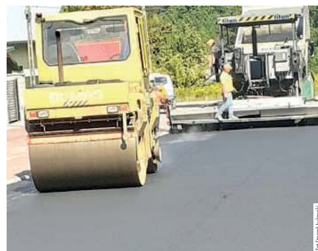
Na ulicy już została położona nowa nawierzchnia, pozostały jeszcze prace wykończeniowe oraz montaż znaków pionowych i poziomych
