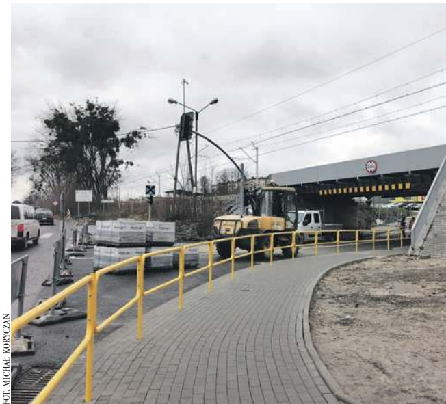
Wiadukt na ul. Krakowskiej w Chrzanowie
