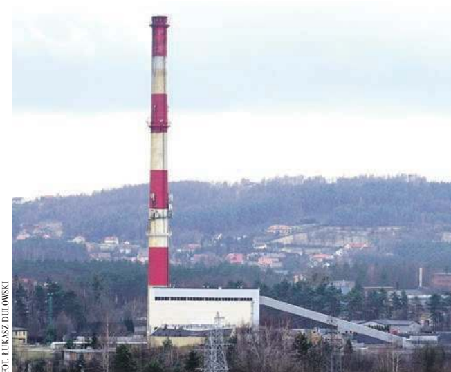
Spalarnia odpadów miałaby powstać na terenie ciepłowni przy Pogorskiej w Chrzanowie. Inwestorem byłaby spółka Veolia Południe
