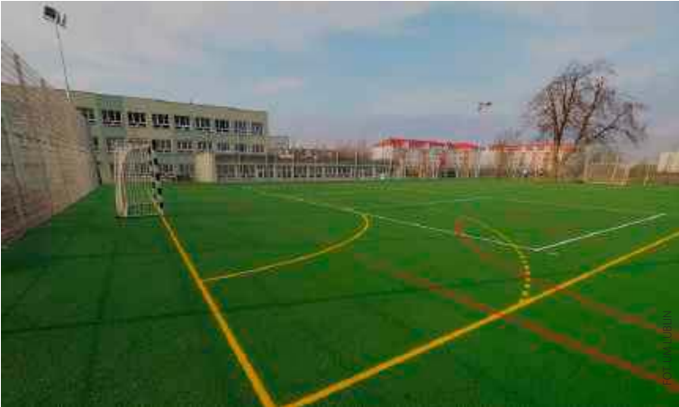
Przebudowane boisko przy SP nr 30 gotowe do gry
