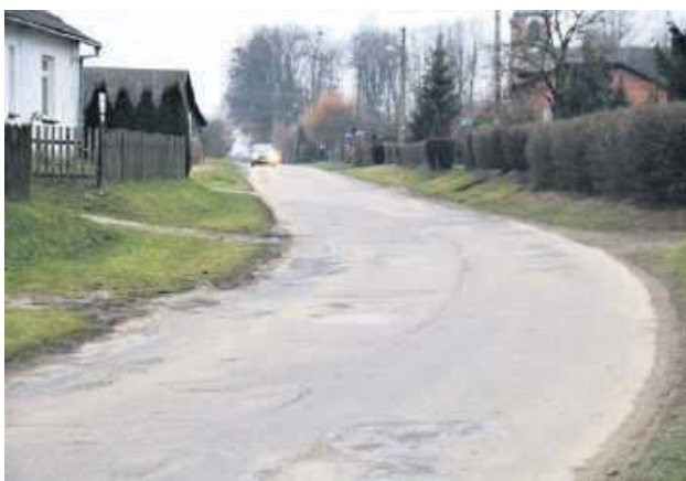
Tą ważną, powiatową drogą codziennie jeżdżą także mieszkańcy Radecznicy, Mokregolipia, Żrebiec, Deszkowic Pierwszych oraz kilku okolicznych miejscowości. Jeśli wszystko się powiedzie, zostanie kompleksowo odnowiona.
