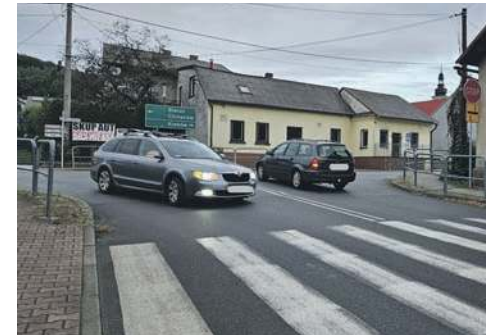
Przejście dla pieszych na skrzyżowaniu Zakopiańskiej i Krakowskiej w Babicach
