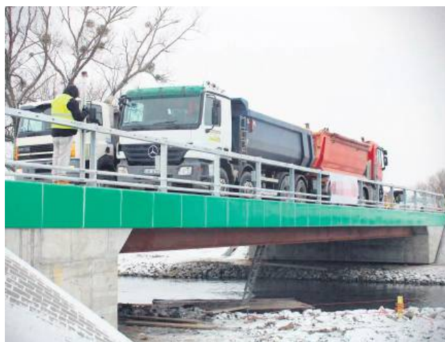
Nowo wybudowany most w Brodzicy pomyślnie wytrzymał obciążenie 128 ton. W jednym czasie ustawiono na nim 4 wielkie ciężarówki.
