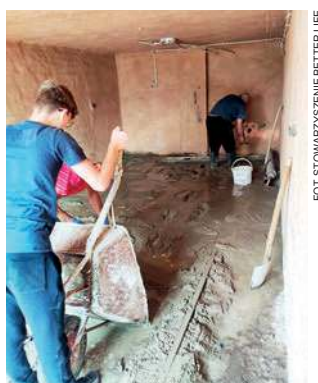
Wakacyjne prace remontowe w powstającym „Miętowym Zakątku”
