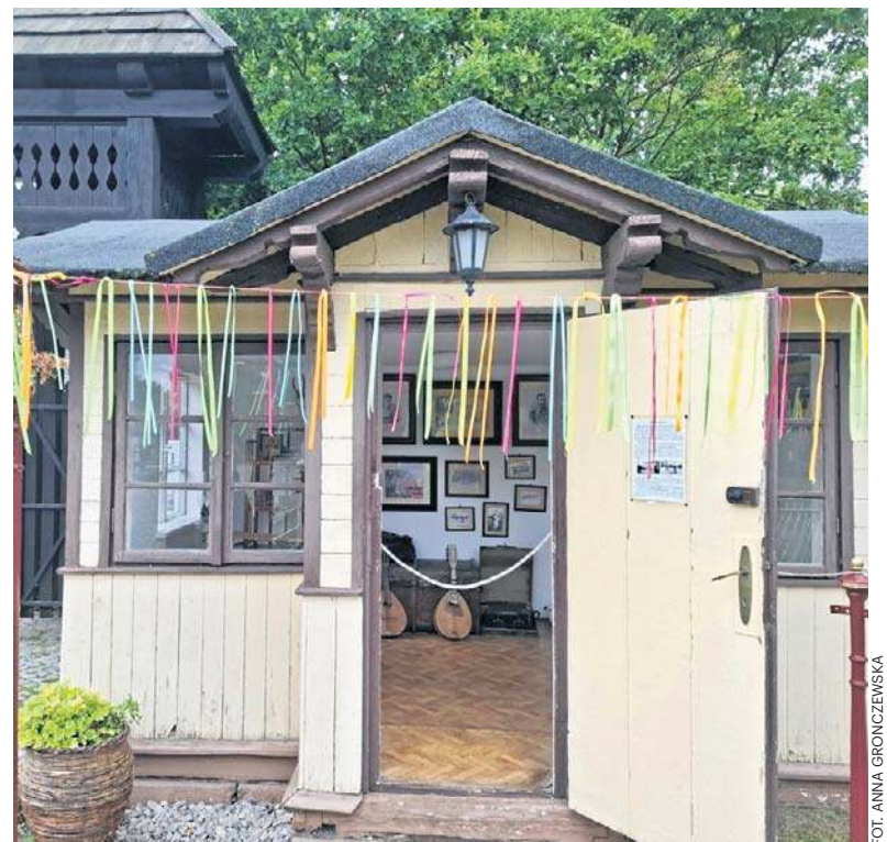
Budynek toalety stał pierwotnie w lasach spalskich
