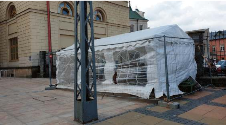
Prace nad poprawieniem parkletu przy ratuszu ciągle trwają
