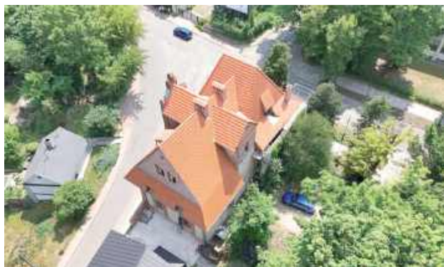
Najbardziej widocznym efektem zakończonego etapu jest odtworzenie historycznej więźby dachowej oraz wykonanie nowego pokrycia z dachówki ceramicznej
