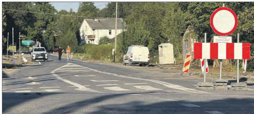
■ Droga na czas remontu została zamknięta
