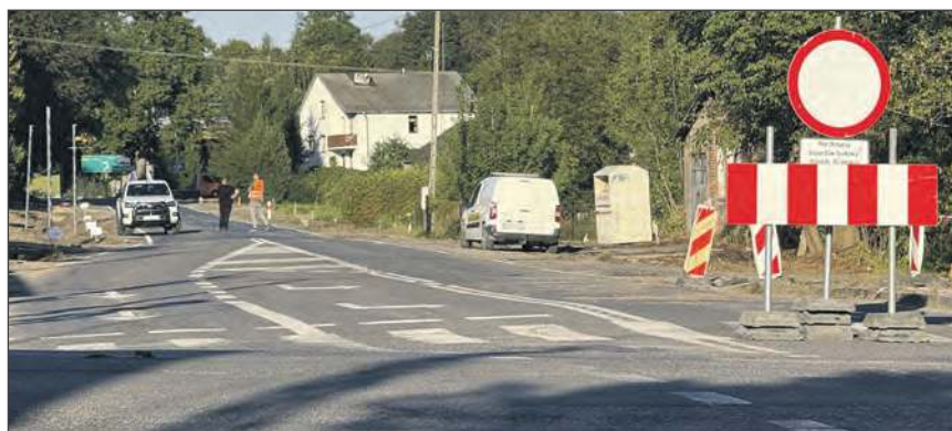
■ Droga na czas remontu została zamknięta
