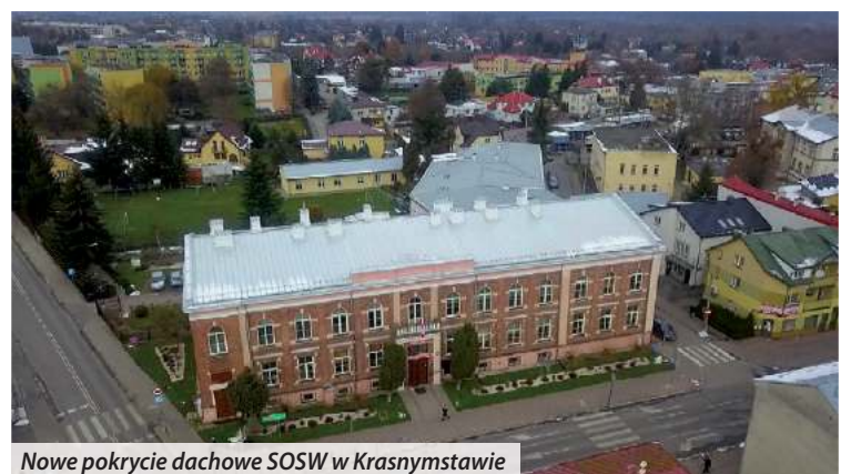
Nowe pokrycie dachowe SOSW w Krasnymstawie
