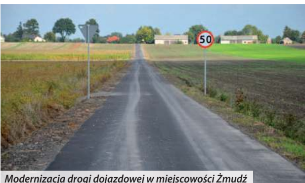
Modernizacja drogi dojazdowej w miejscowości Żmudź
