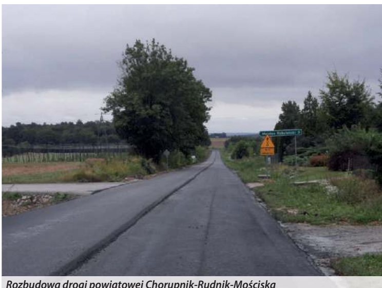
Rozbudowa drogi powiatowej Chorupnik-Rudnik-Mościska
