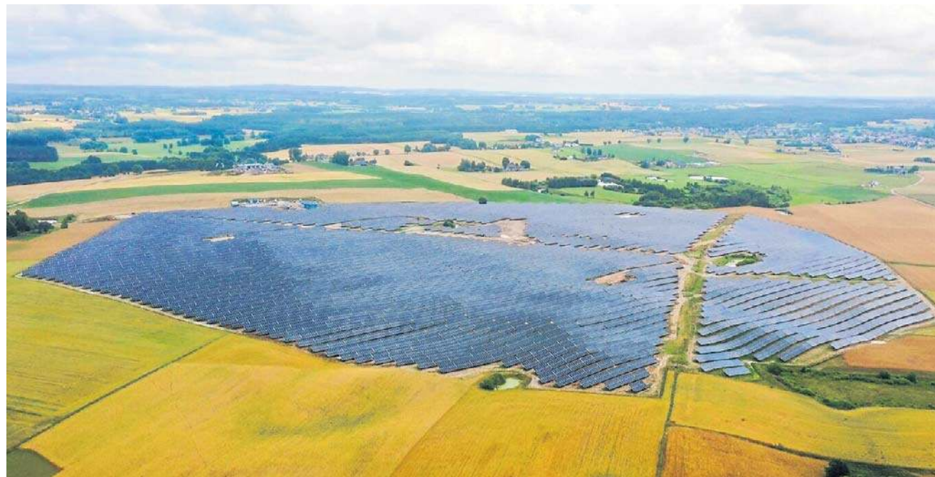
Farma fotowoltaiczna PV Łosienice w gminie Stężyca została już przyłączona do sieci elektroenergetycznej
