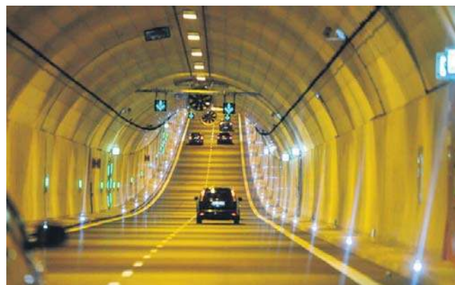
Od 10 lat jeździmy tunelem. Obiekt składa się z dwóch jezdniowych rur po dwa pasy ruchu każda
