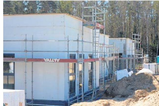
Żłobek powstaje w technologii modułowej, co pozwala na tak szybkie prace. Będzie można też go rozbudować
