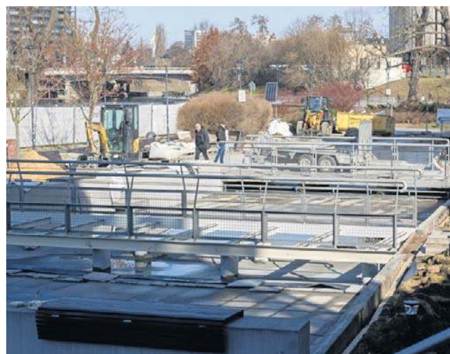
Aktualnie trwa drugi etap robót przy rewitalizacji Wyspy Młyńskiej w Bydgoszczy
