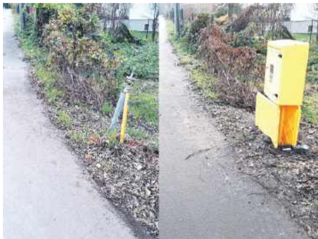
Rury po naszej interwencji zostały obudowane
