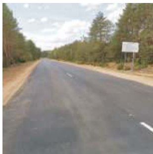
Przebudowana droga Nr H-424 po stronie białoruskiej
