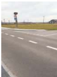
Przebudowana droga powiatowa nr 1051L
