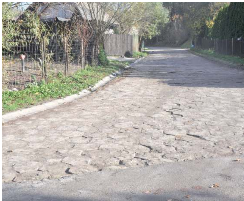
Mieszkańcom Podgórza szczególnie zależało na przebudowie tego odcinka, na którym znajdują się złuszczone betonowe płyty
