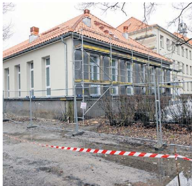
W Zespole Szkół Chemicznych w Bydgoszczy trwa kompleksowa termomodernizacja
