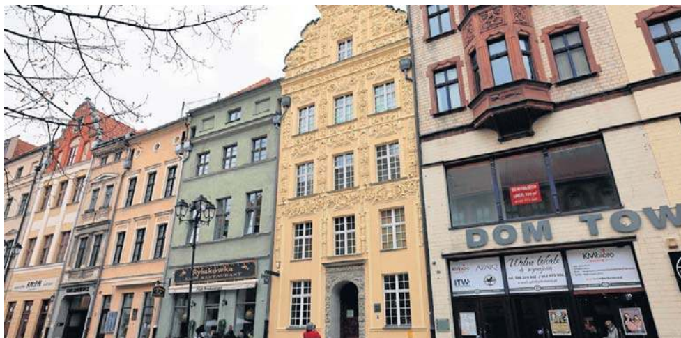
Remont budynku przy Rynku Staromiejskim 35 w Toruniu rozpoczął się na początku 2025 roku i trwał około roku. Objął między innymi elewację
