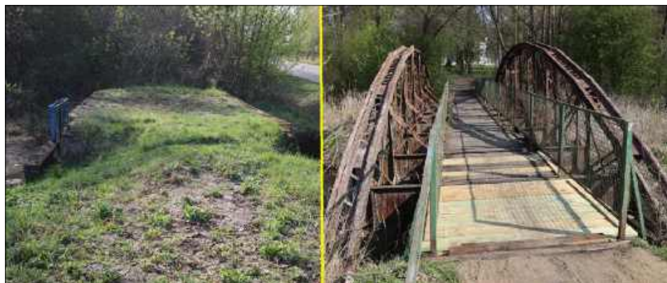
Żelazny most na Klukówce i most w Ciciborze Małym, niegdyś składowe Bialskiej Kolejki Dojazdowej, trafiły do rejestru zabytków
