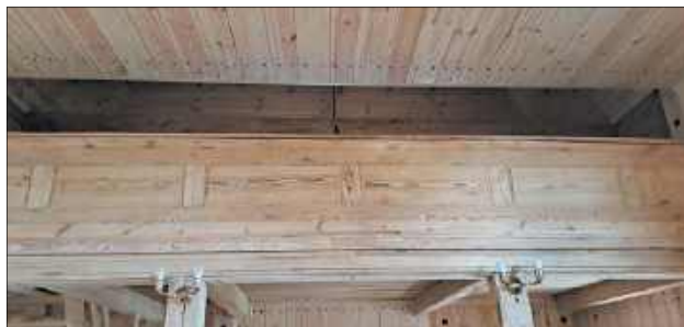
W czasie remontu odkryto też chór, tak by mógł ponownie grać na nim organista
