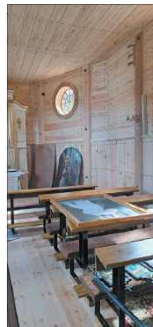
Wyremontowano też wnętrze kościoła, obecnie obrazy czekają na oprawienie i zawieszenie na ścianach
