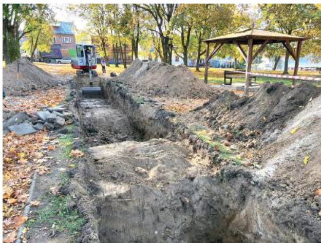
Prace wykonuje wyspecjalizowana firma z Lublina. Będą kosztowały blisko 100 tys. zł
