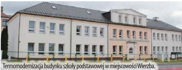
Termomodernizacja budynku szkoły podstawowej w miejscowości Wierzba.
