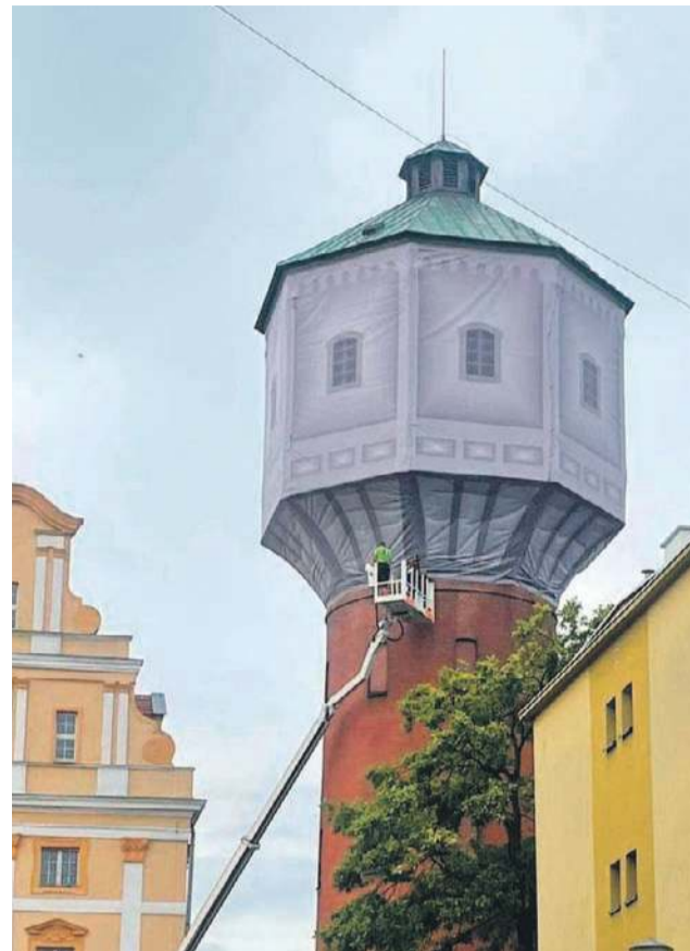
Od dawna wieża jest zabezpieczona siatką, mającą zabezpieczyć przed ewentualnymi kawałkami spadającego tynku
