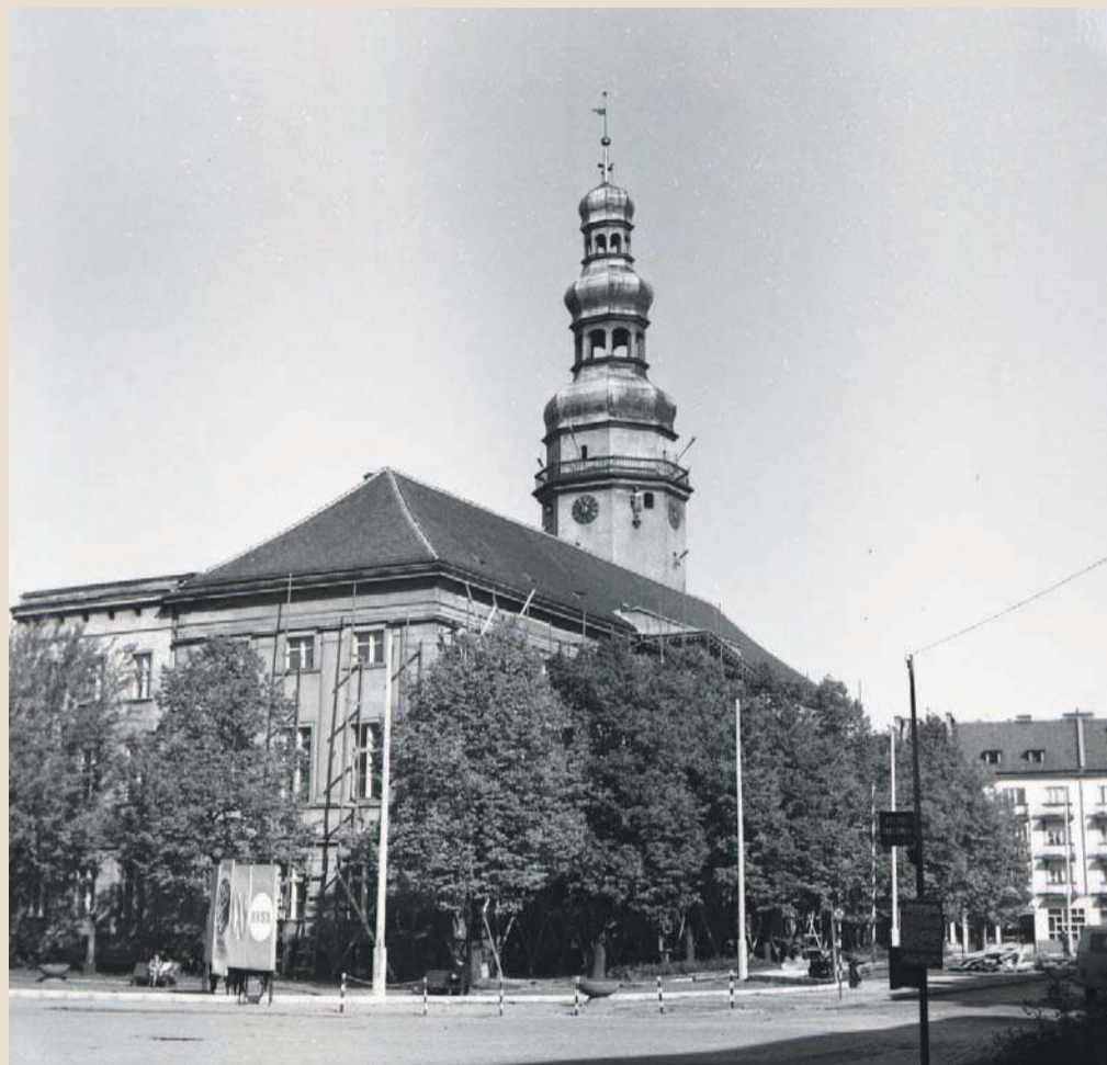
Rok 1970, remont elewacji ratusza, drewniane rusztowania stoją wciśnięte pomiędzy budynkiem a lipami, konary drzew nie są zabezpieczone
