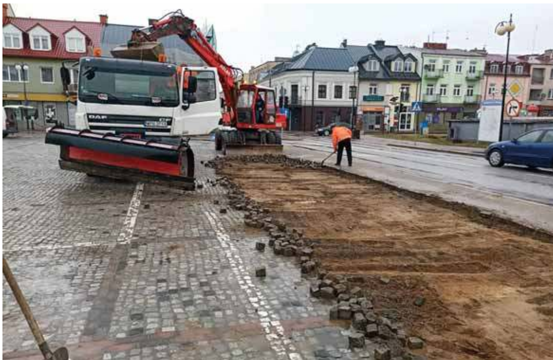
Roboty na placu 15 Sierpnia mają być wykonywane etapami
