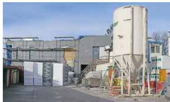
Tak wygląda obecnie plac budowy CO-M
