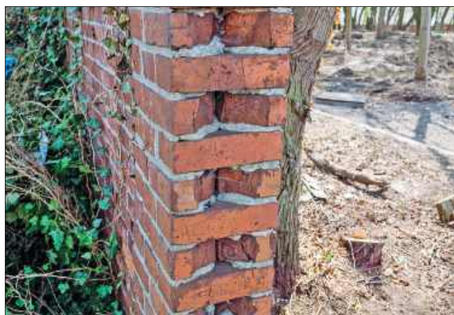
■ Strzępia w murze świadczą o tym, że przewidywano jego rozbudowę
