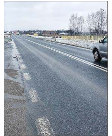
Na tym odcinku doszło do wypadku.
