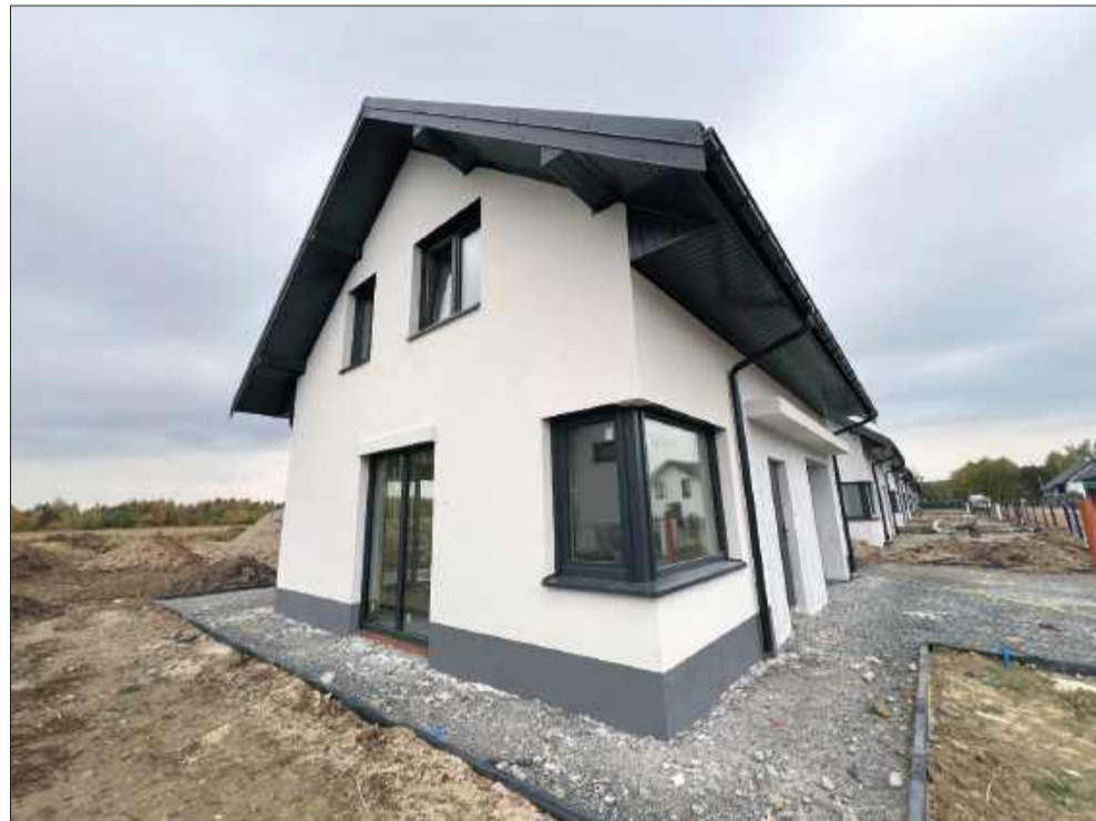
Przemysłany układ pomieszczeń i wysoki standard wykończenia.
