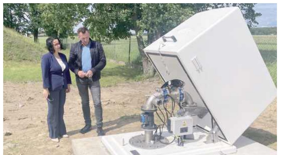
Dokonano odbioru końcowego realizacji zadania inwestycyjnego pn. „Przebudowa stacji uzdatniania wody na terenie gminy Żelechów”
