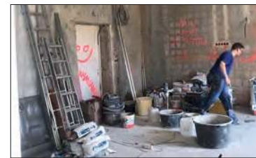
Jedno z kilku miejsc w szpitalu, gdzie prowadzone są prace remontowe
