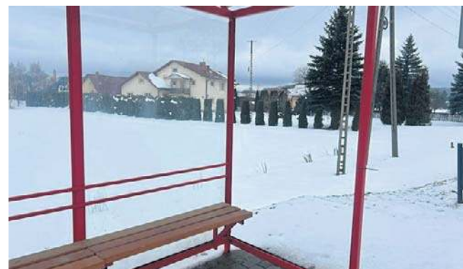
Pozbawiona ścianek wiata przystankowa naraża podróżnych na podmuchy mroźnego wiatru i śniegu
