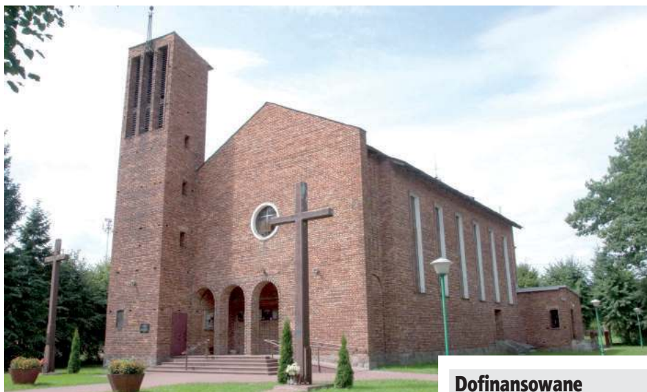
W kościele w Turowie zostanie wykonana wymiana pokrycia dachowego wraz z montażem odwodnienia dachu
