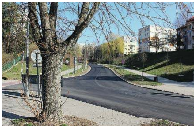
Wyremontowana nawierzchnia na ul. Barcza w Olsztynie
