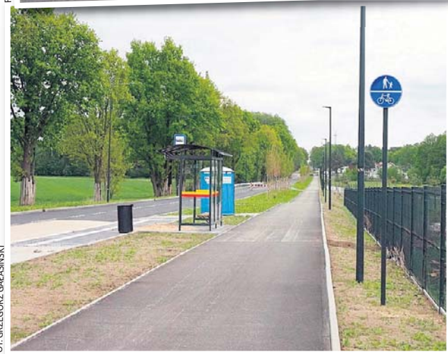
Nowo wyremontowany odcinek Szczecińskiej na granicy Łodzi i Konstantynowa.
