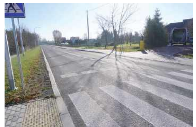
Prace rozpoczęły się w kwietniu 2024 roku, a zakończyły latem 2025 roku
