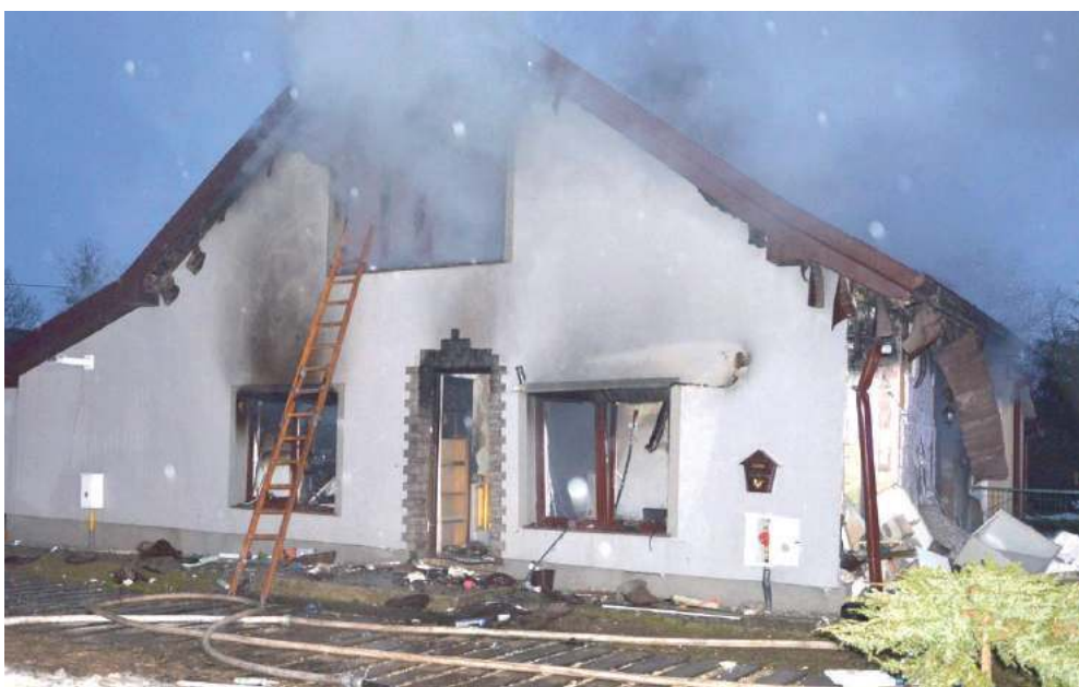
Do zdarzenia doszło w piątkowe popołudnie w Podedwórz. Budynek został poważnie uszkodzony
